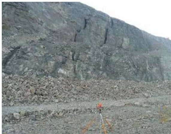
Рисунок 7.37 – Деформации западного борта Соколовского карьера
