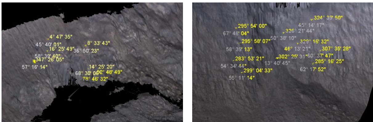
Рисунок 5.8 – Определение элементов залегания трещин
