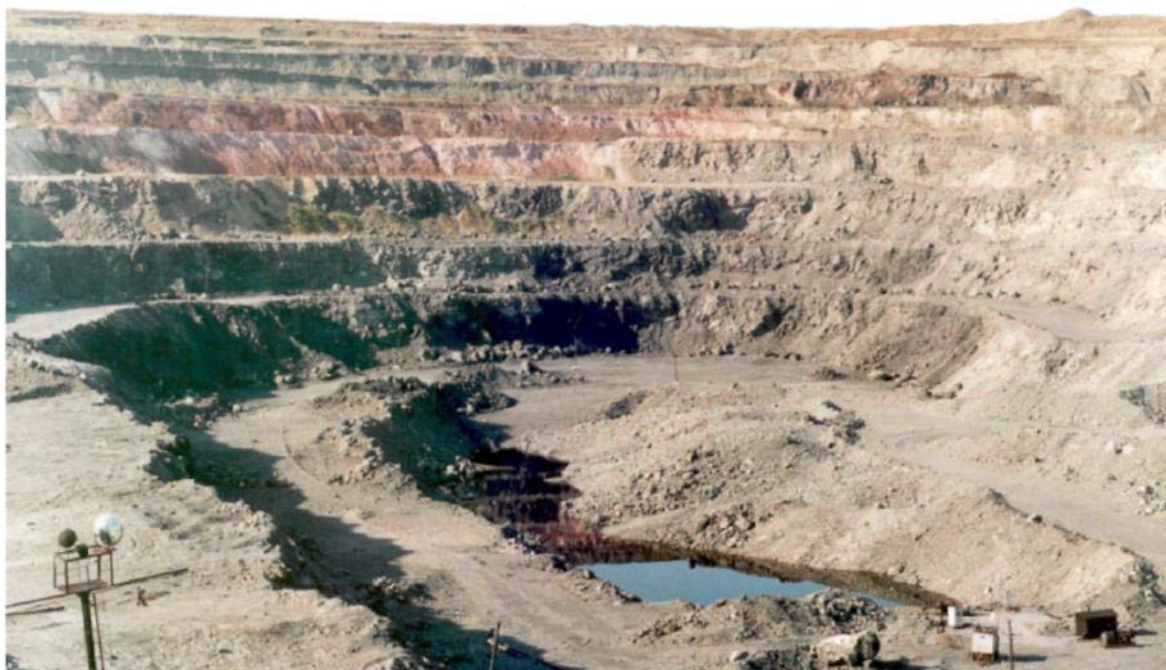
Рисунок 2.14 – Состояние горных работ на карьере «Куржункульский»
