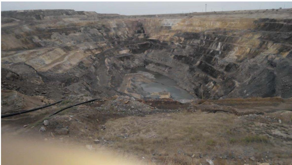
Рисунок 2.16 – Состояние горных работ на карьере Восточный Камыс
