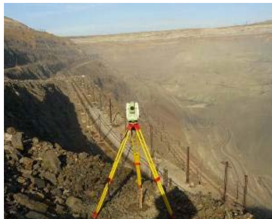
Рисунок 7.38 – Инструментальный контроль западного борта Соколовского карьера
