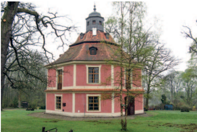
Svatý Hubert u Jesenice (okr. Rakovník), zámek pavilónové dispozice. Ústřední oktogonální stavba v kruhu obklopovalo zhruba osm dalších staveb. Foto David Tuma, 2018.
