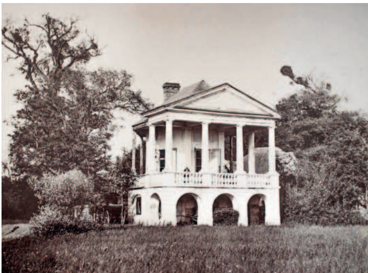
Lovecký zámek (Lednicko-valtický areál) (okr. Břeclav). Stavba sloužila jako hájovna s bytem lovčího v přízemí a z terasy umožňovala panstvu sledovat parfosní hony konané na louce před hájovnou. Navazující osmiboký salon přístupný francouzským oknem poskytoval příležitostný útulek účastníkům honu k podávání občerstvení. Original-Aufnahmen von forstwirtschaftlichen Objecten auf den Besitzungen Srov. Durchlaucht des regierenden Fürsten Johann von und zu Liechtenstein.
